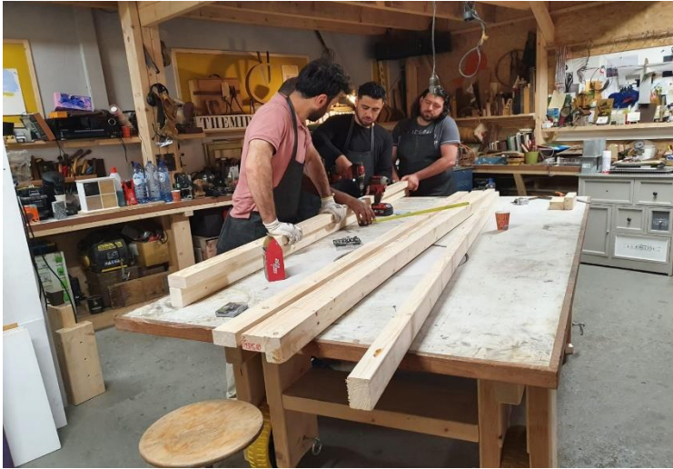
Balken op lengte zagen...
